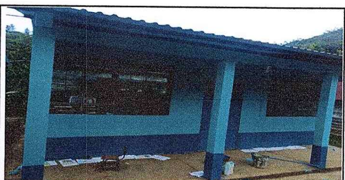
Foto 6: REHABILITACIÓN DEL MÓDULO 3
