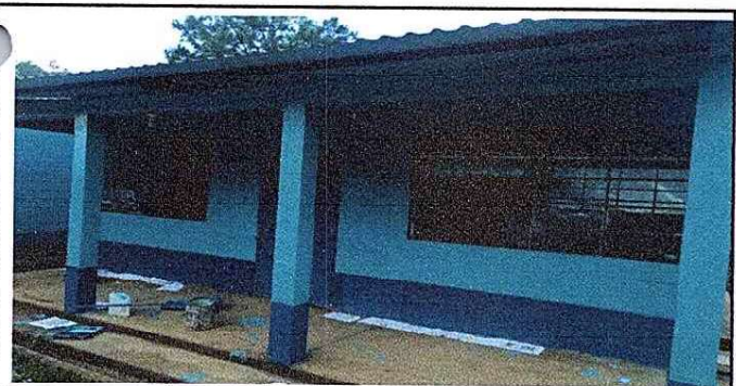
Foto 5: REHABILITACIÓN DEL MÓDULO 3
