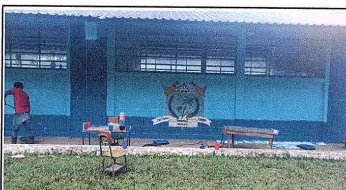
Foto 4: APLICACIÓN DE PINTURA EN LOS EXTERIORES E INTERIORES DEL MÓDULO 1
