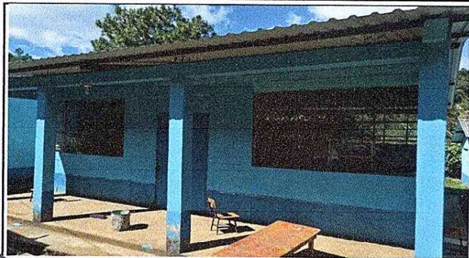
Foto 1: SUSTITUCIÓN DE PUERTAS DE METALES DEL MÓDULO 3
